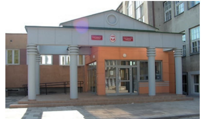
Wejście do szkoły przebudowane w 2009 roku
